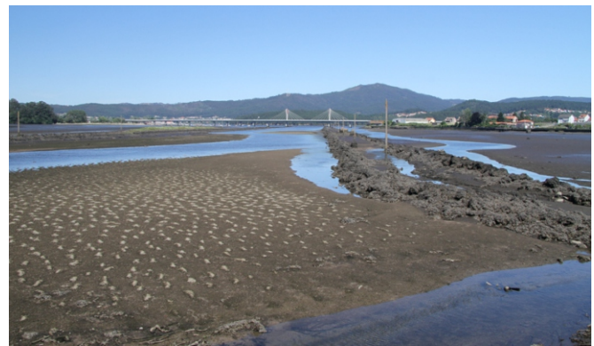
A ría, a ponte nova e a canle de navegación
