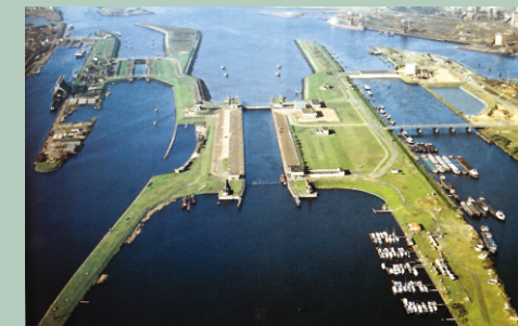
Diques construídos en Holanda para gañar terreo ao mar.
