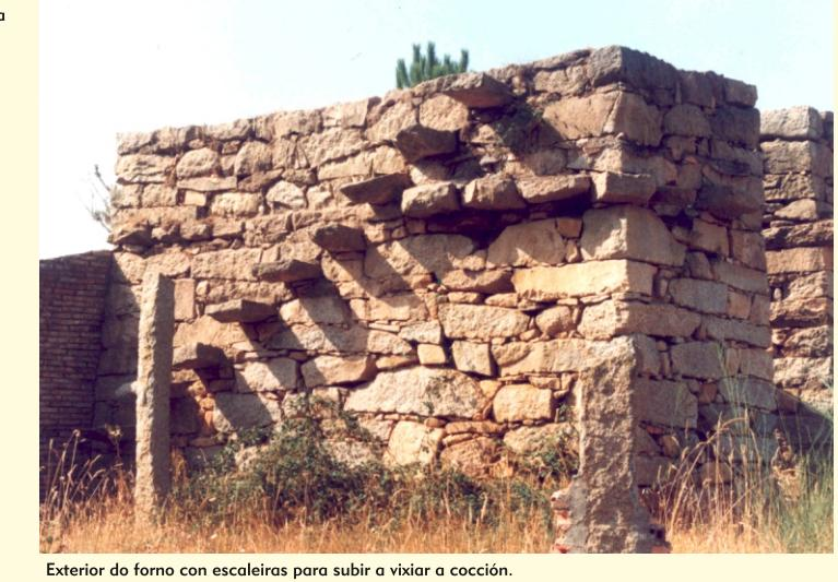
Exterior do forno con escala para subir a vixiar a cocción.
